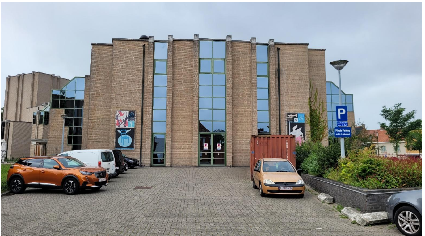
Achterkant, laad-en los. De poort zit achter de dubbele glazen deur
